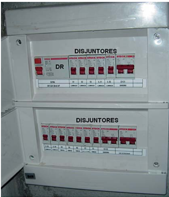
Figura 3 - Modelo de quadro elétrico terminal (uso em pequenas unidades) Fontes: Steck e Procobre
